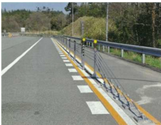
《ワイヤロープ設置工事》
