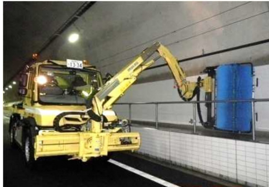
《トンネル側壁清掃》
