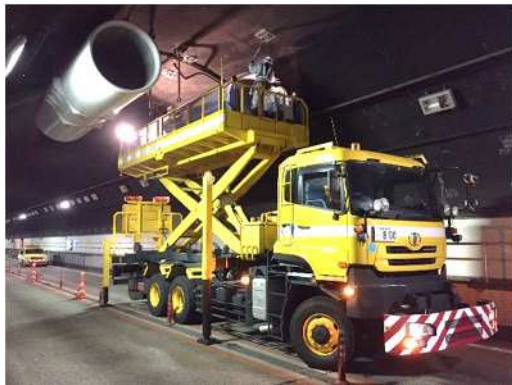
《トンネル設備清掃・点検》
