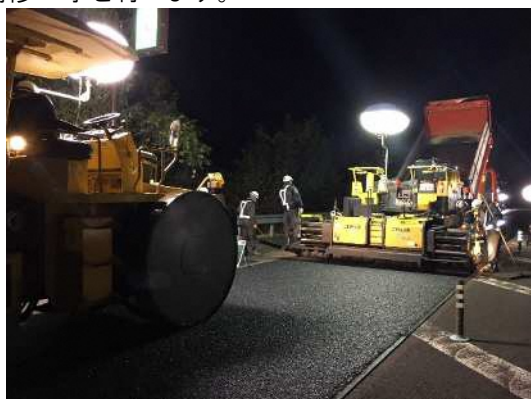
《舗装補修工事》
