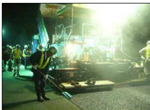
《舗装補修工事》
