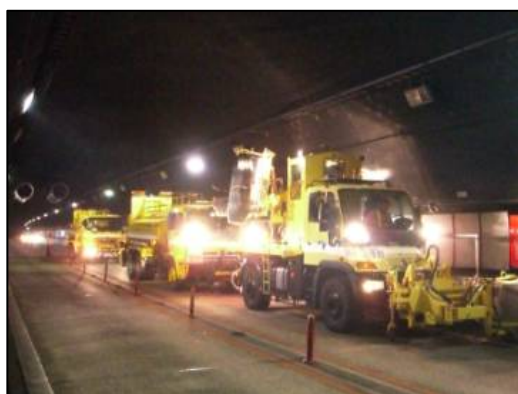
《トンネル側壁清掃》
