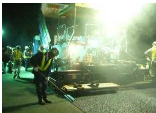
《舗装補修工事》
