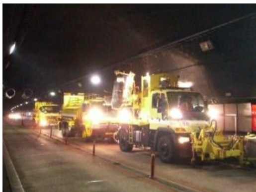
《トンネル側壁清掃》
