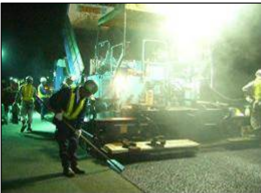
《舗装補修工事》
