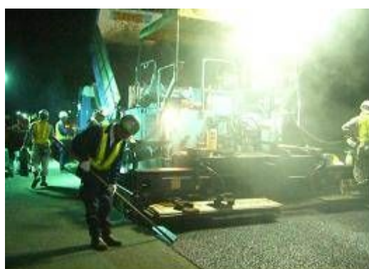
《舗装補修工事》
