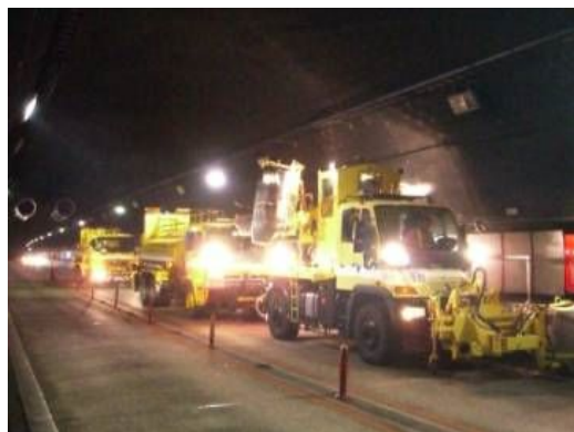
《トンネル側壁清掃》
