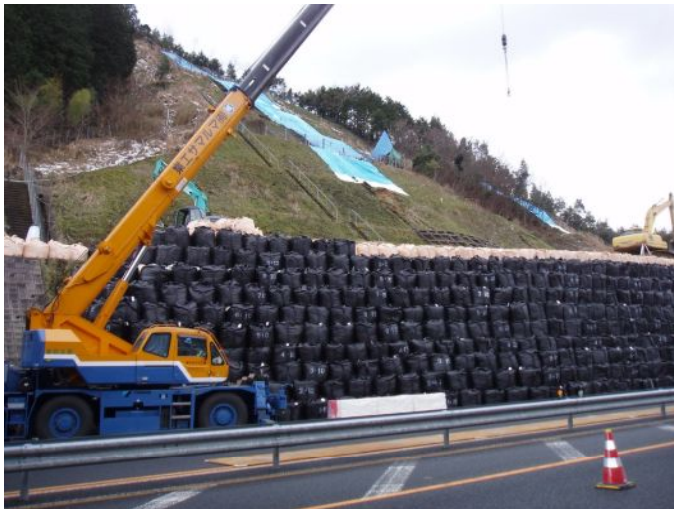
[押さえ盛土と大型土のう設置状況]
