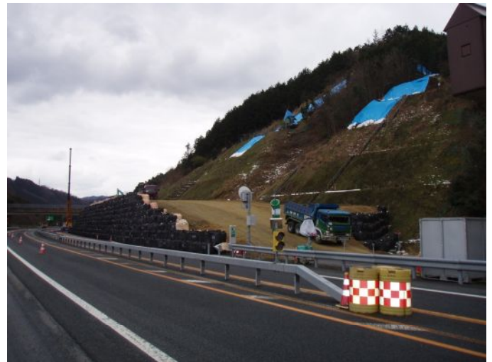
[押さえ盛土の施工状況]
