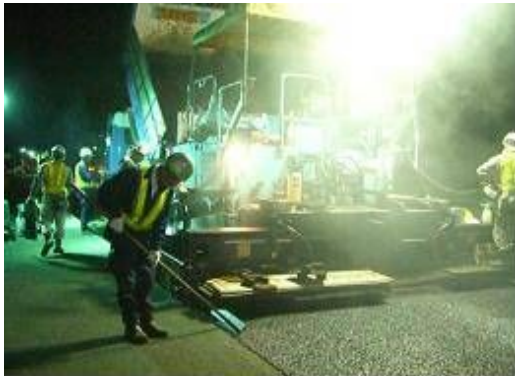
《舗装補修工事》
