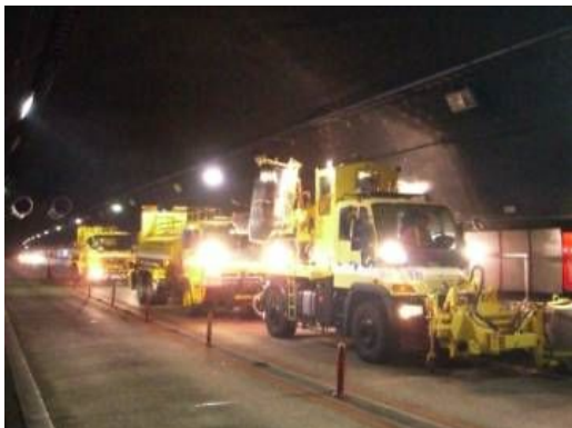
《トンネル側壁清掃》
