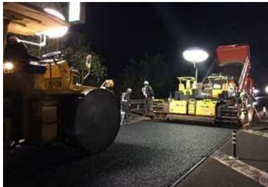
《路面損傷箇所の補修》
