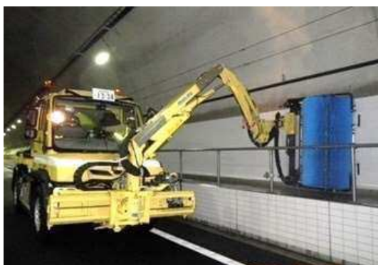
《トンネル側壁清掃》
