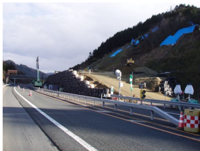
[押さえ盛土の施工状況]
