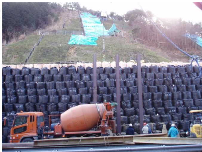
[仮設防護柵の設置状況]
